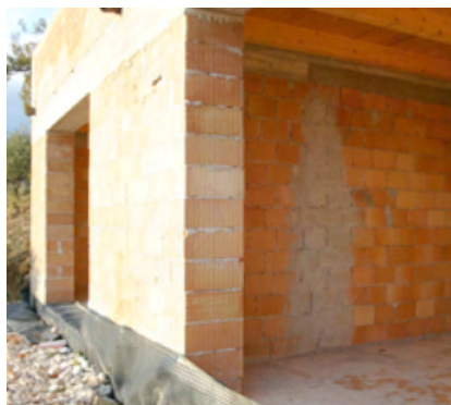
Vista delle murature portanti al piano terra
